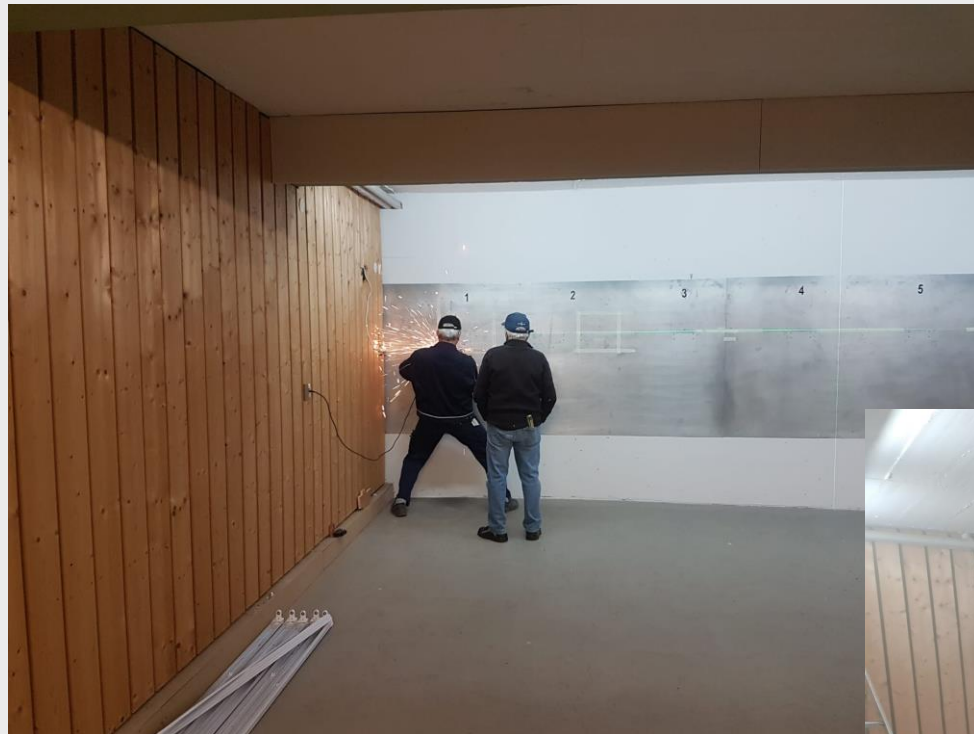
Ausschneiden der Stahlwand
