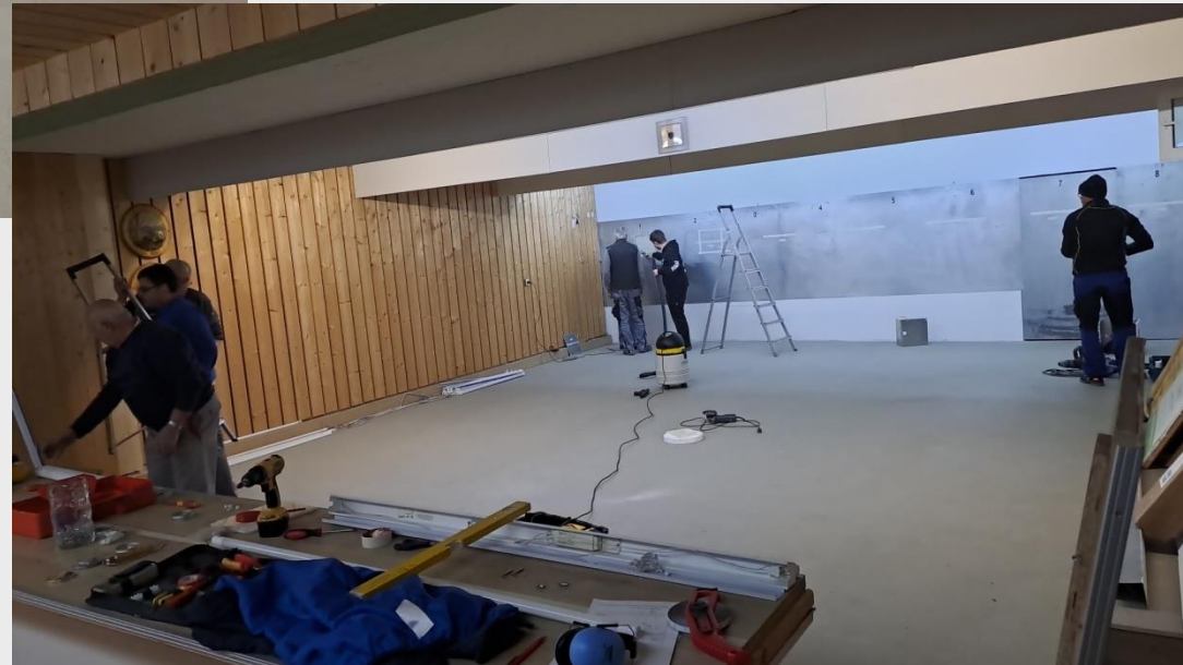
Anzeichnen der Versenkungen Umbau der Beleuchtung
