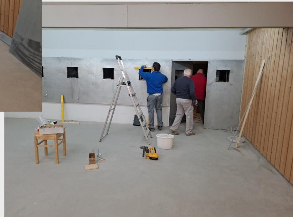
Stahlwand wieder dran Einbau der Ziel-Halterungen
