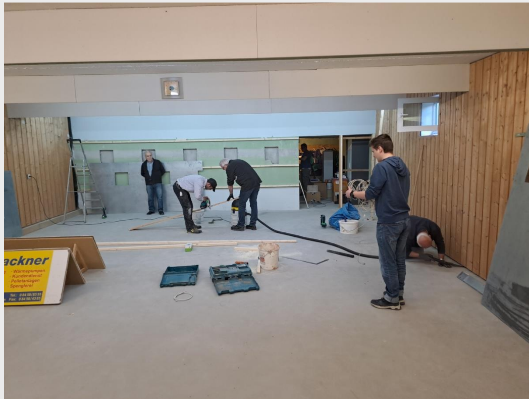
Bau der Unterkonstruktion Verlegen der Verkabelung
